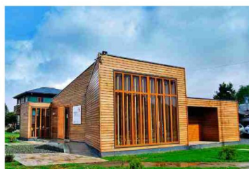
En dos años se han puesto en marcha los centros de San José de la Mariquina, Constitución y Curanilahue.
